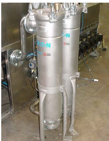
Duplex Filterpatronen oder Filtersäcke bis zu 50 µm
